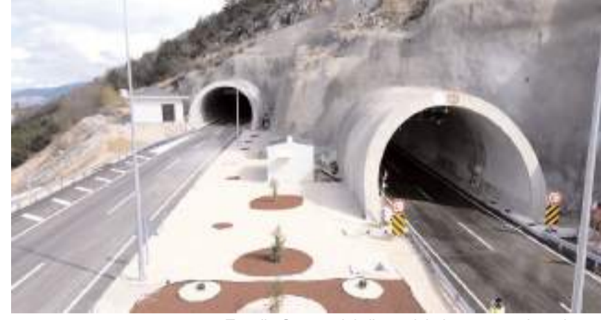
Tünelin Osmancık istikameti, bakım ve son düzenleme çalışmaları nedeniyle geçici olarak trafiğe kapatıldı.
