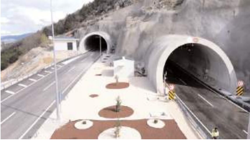
Tünelin Osmancık istikameti, bakım ve son düzenleme çalışmaları nedeniyle geçici olarak trafiğe kapatıldı.
