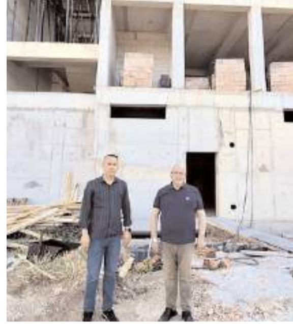
İl Millî Eğitim Müdürü Cemil Çağlar, İnşaatlardan Sorumlu Şube Müdürü Müslim Kılıç ile birlikte Silimkent TOKİ İlkokulu inşaatında incelemede bulundu.
