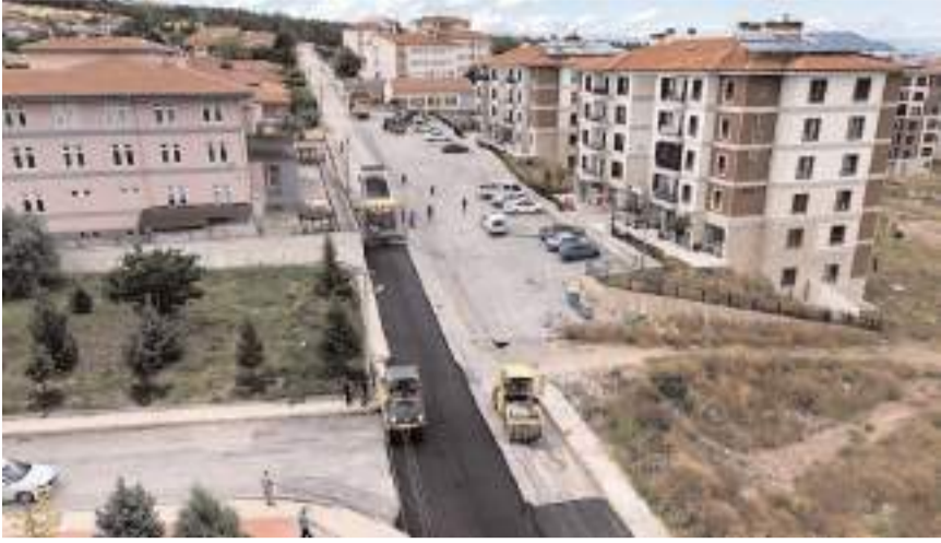
Belediye Dodurga'da 2 bin ton asfalt serdi.
