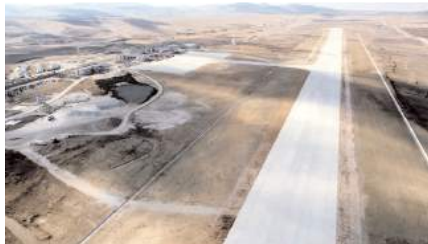
Yapımı devam eden Yozgat Havalimanı...
