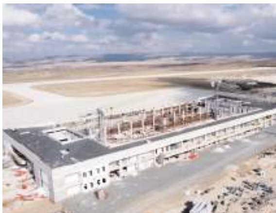
Yapımı devam eden Yozgat Havalimanı...
