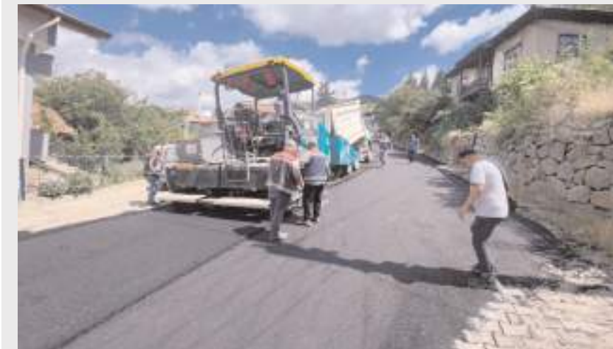
Asfalt çalışmasını Çorum Belediyesi yapıyor.
