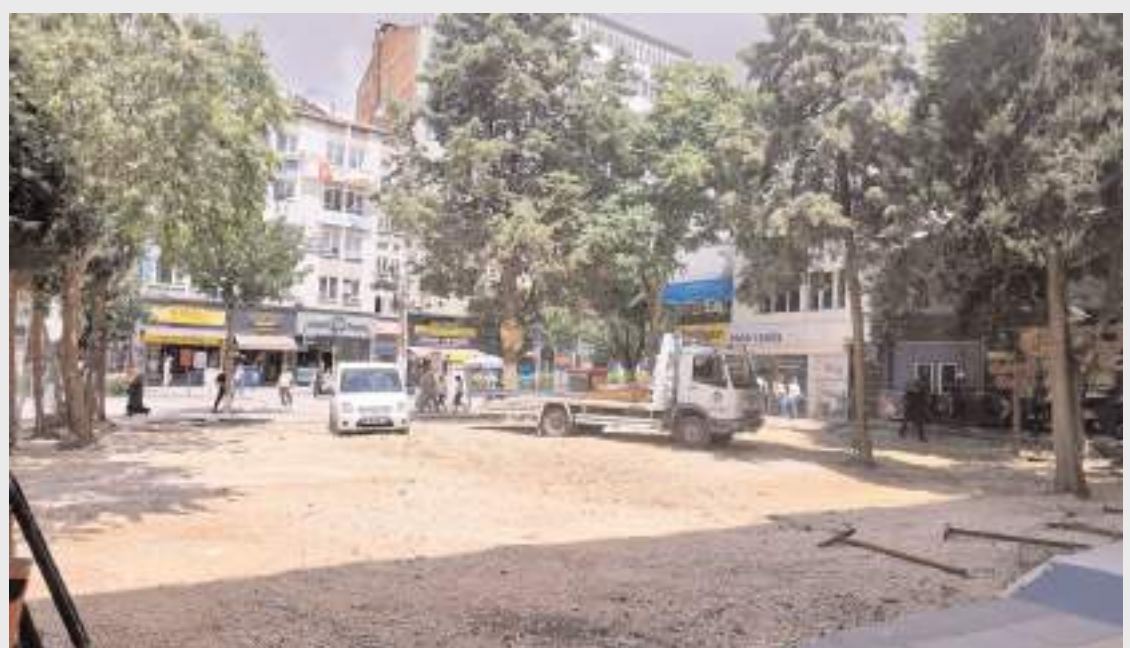
Uzun yıllardır hizmet veren Küçük Ev Kafe'nin yıkımı tamamlandı.
