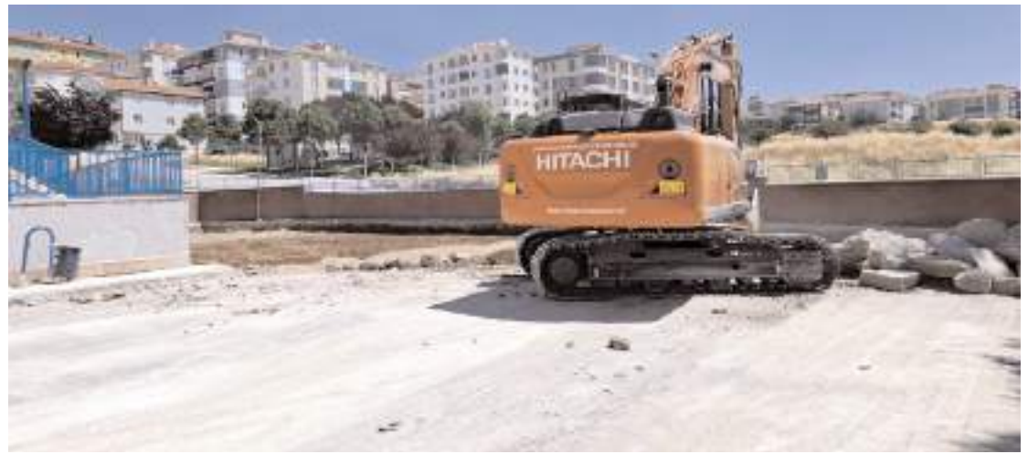
Çorum Belediyesi tarafından okul bahçeleri asfaltlanacak.
