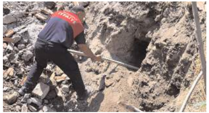
İtfaiye ekipleri, yıkım alanında yaptıkları çalışmalar sonucunda mahsur kalan 8 yavru köpeğin yerini tespit etti.
