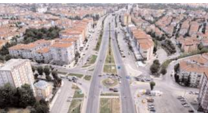
İlim Yayma Kavşağı farklı seviyeli (köprülül) kavşak olarak inşa edilecek.
