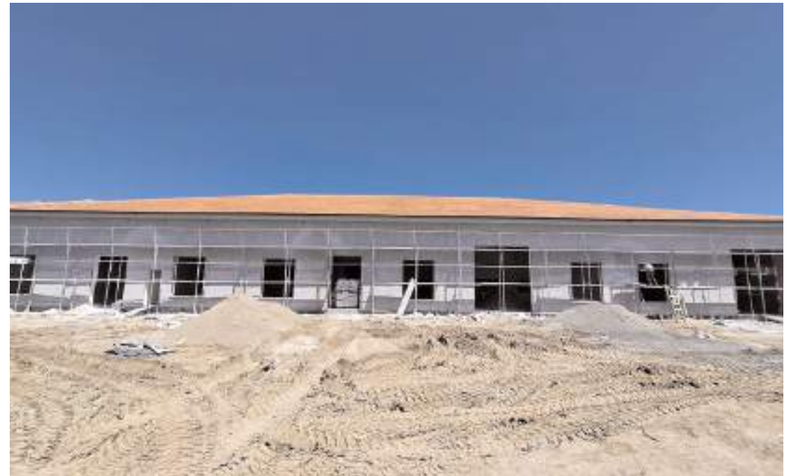
Atölye Şehit Öğretmen Fatih Tekin Mesleki Eğitim Merkezi bahçesine inşaa ediliyor.
