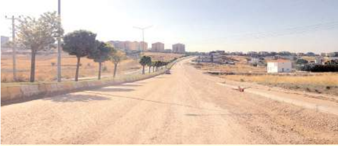
Mıcır serilen yol asfalt yapılmayı bekliyor.
