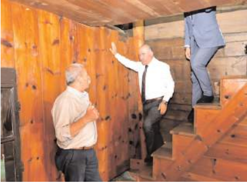
Vali Ali Çalgan, Akşemseddin Camii'nde incelemede bulundu.
