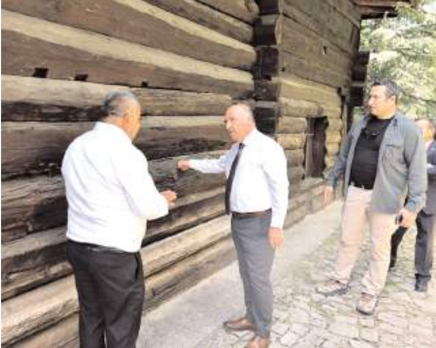
Akşemseddin Hazretleri tarafından inşa ettirilen cami ahşaptan çivisiz olarak yapılmış.
