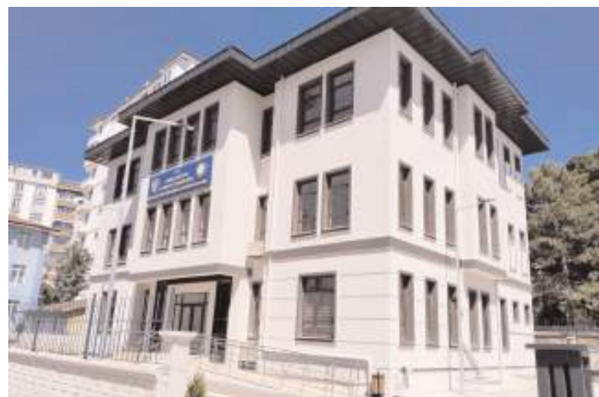
Şehit Emre Beker Bahçelievler Mahalle Karakolu
