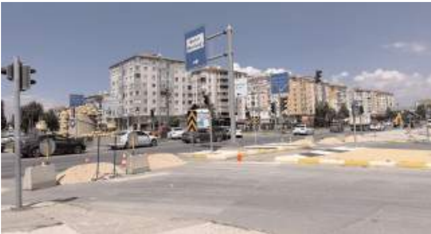
Yüklenici firma ekipleri ana yolun trafiğinin aktarılacağı yan yolları yapıyor.
