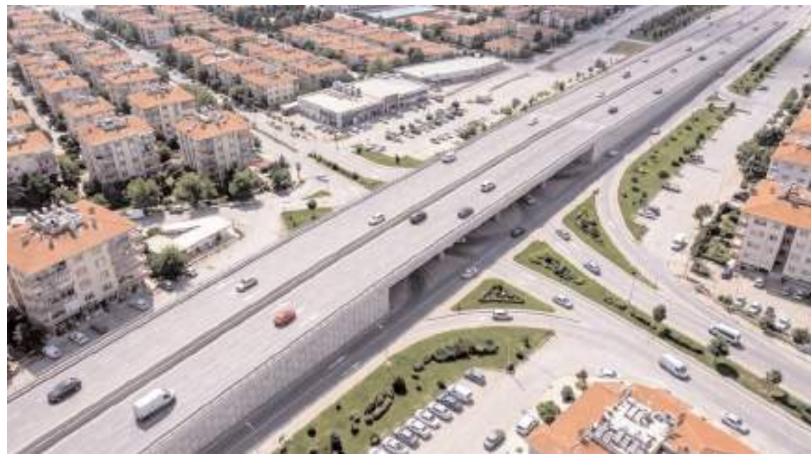
Kavşakta çalışmaların 6 ay içinde tamamlanması bekleniyor.
