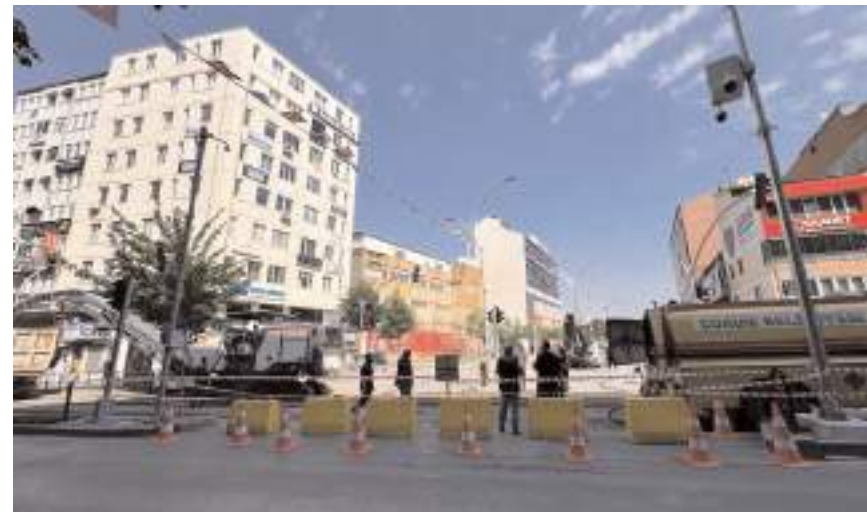
Yenileme çalışması nedeniyle caddeye bağlanan yollar kapatıldı.
