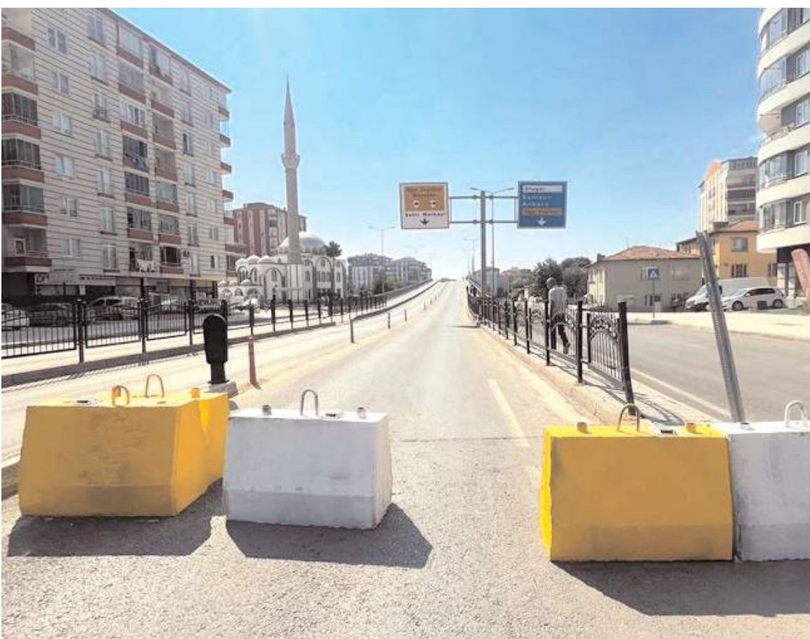
Osamancık Kavşağı Üst Geçidinde şehir merkezine gidişler trafiğe kapatıldı.
