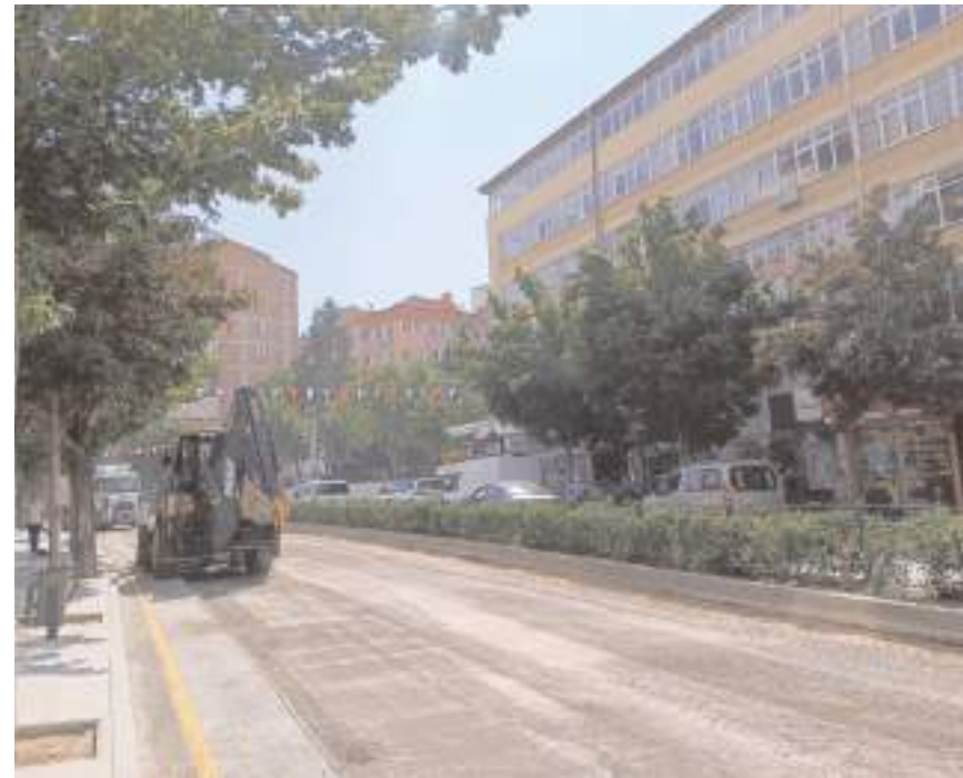
Yıpranan asfalt tamamen kaldırılıyor.
