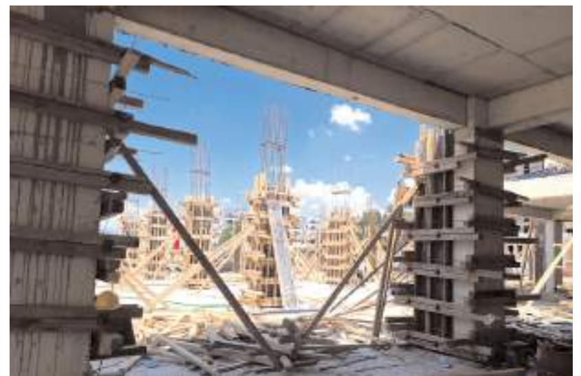
Plaza inşaatı planlanan takvim doğrultusunda hızla ilerliyor.
