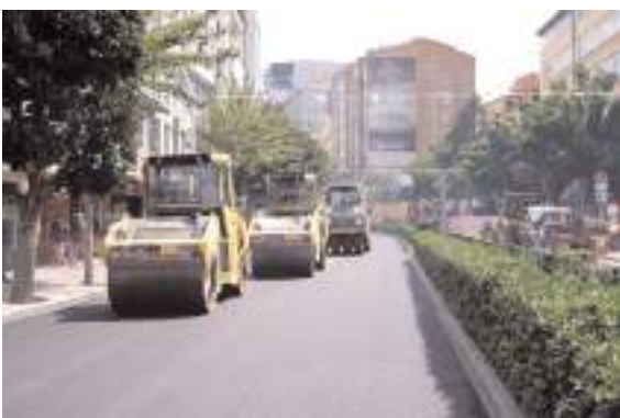
Gazi Caddesinin Valilik ile Saat Kulesi arasında kalan bölümünde yenileme çalışmaları hızla devam ediyor.
