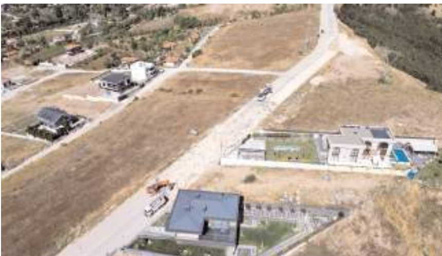
YEDAŞ, Çorum Gaz, Türk Telekom ve Çorum Belediyesi altyapı yenileme çalışmaları yapacak.
