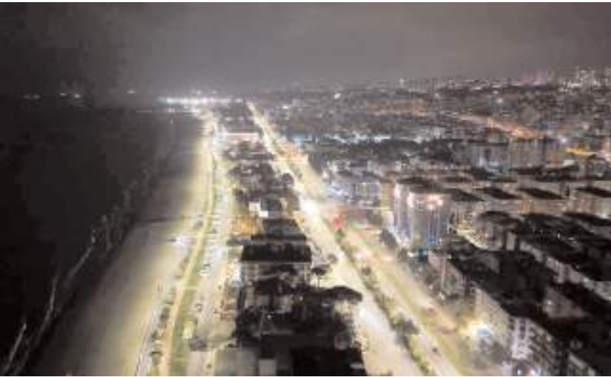
YEDAŞ hizmet bölgesinde 45 bin sokak aydınlatmasını LED armatürlerle yeniledi.
