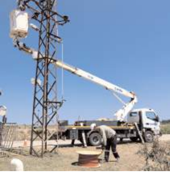
YEDAŞ hatlarda izolasyon çalışması yaptı.
