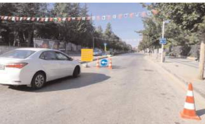
Belediye Valilik ile Meslek Yüksekokulu arasındaki güzergâhta asfalt yenileme çalışmaları başladı.
