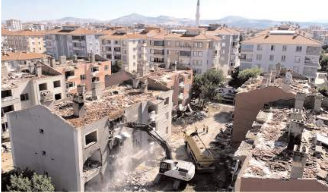
Boşaltılan binalarda yıkım çalışmaları başladı.
