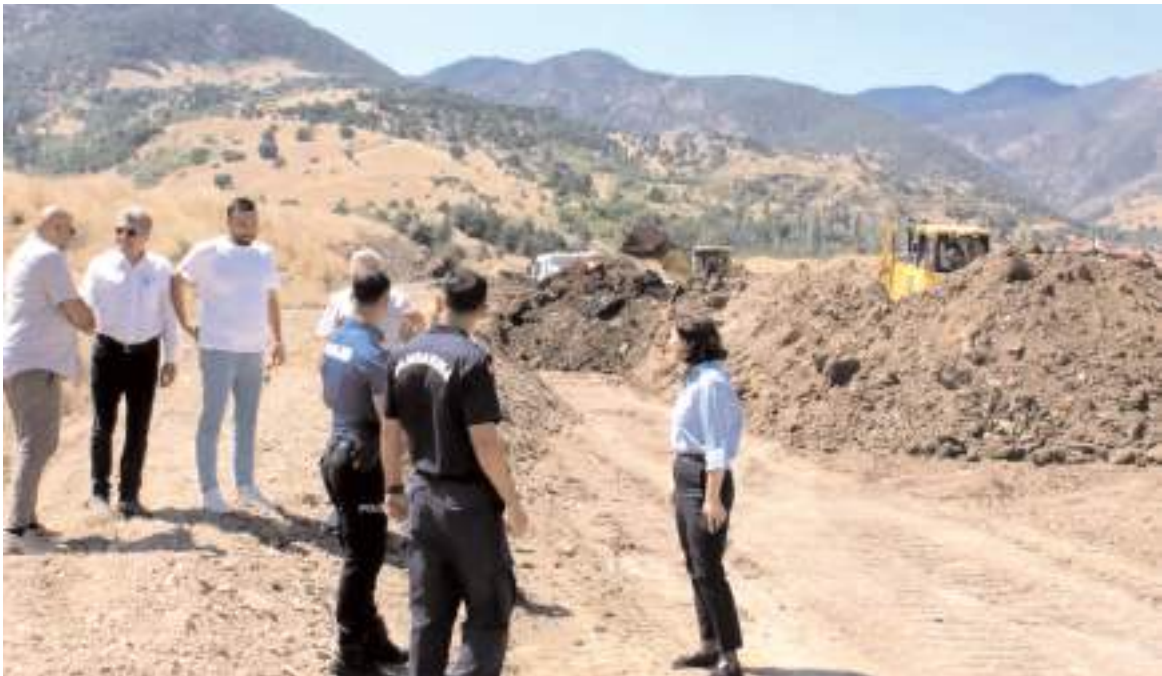
Kaymakam Tokur, Alpogut Köyü'nde devam eden yol yapım çalışmalarını inceledi.
