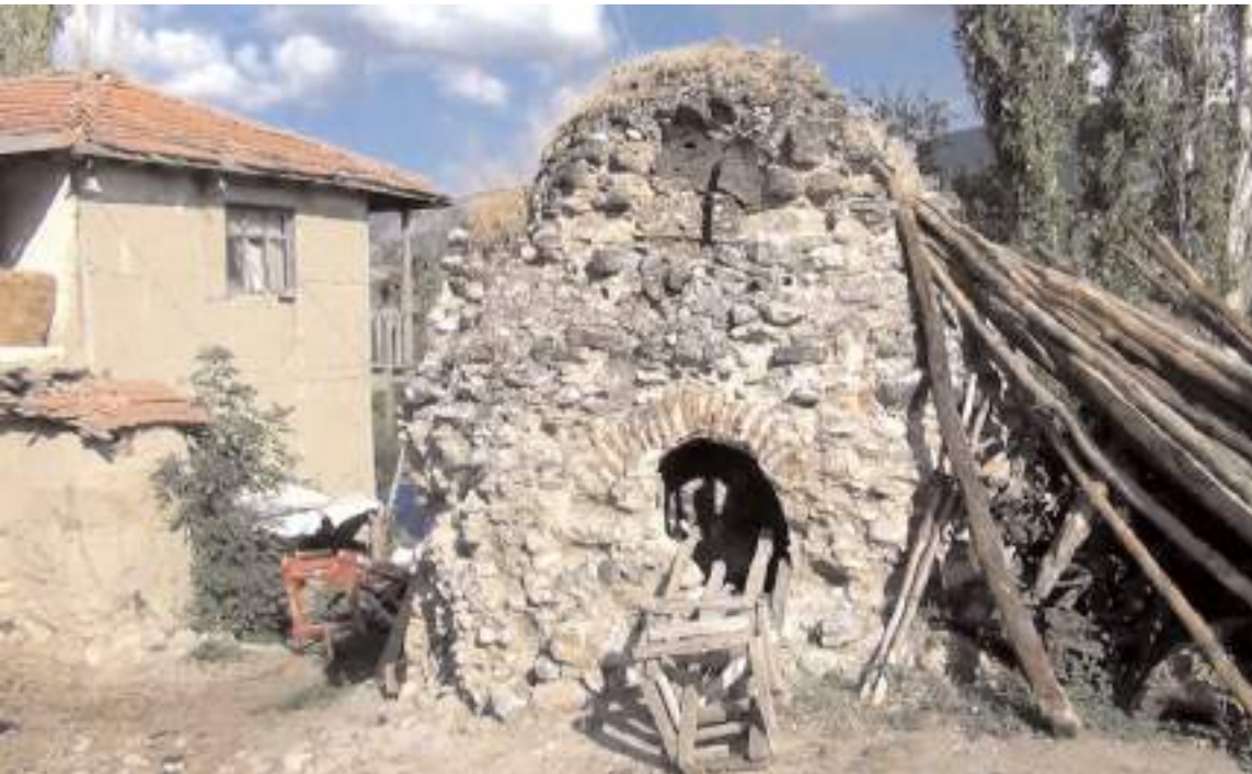
Mecitözü'ne bağlı İbek köyünde bulunan atıl vaziyetteki tarihi hamam zamana direniyor.
