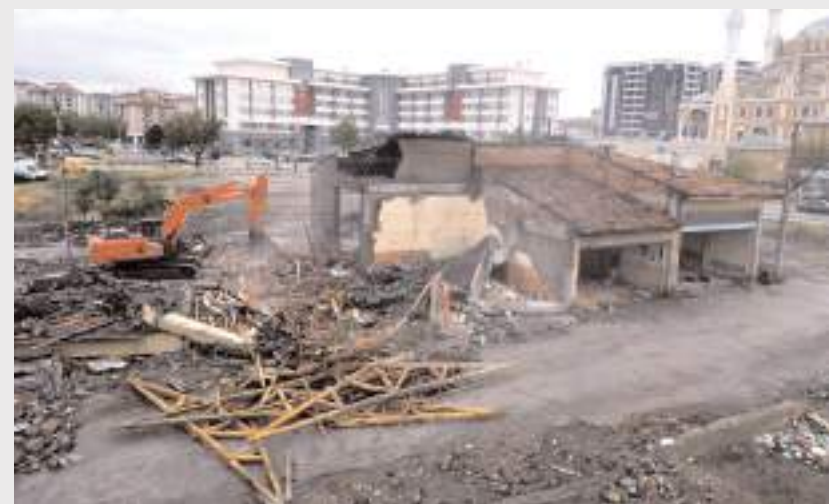
Kamulaştırılan alanlarda yıkım çalışmaları yapılıyor.
