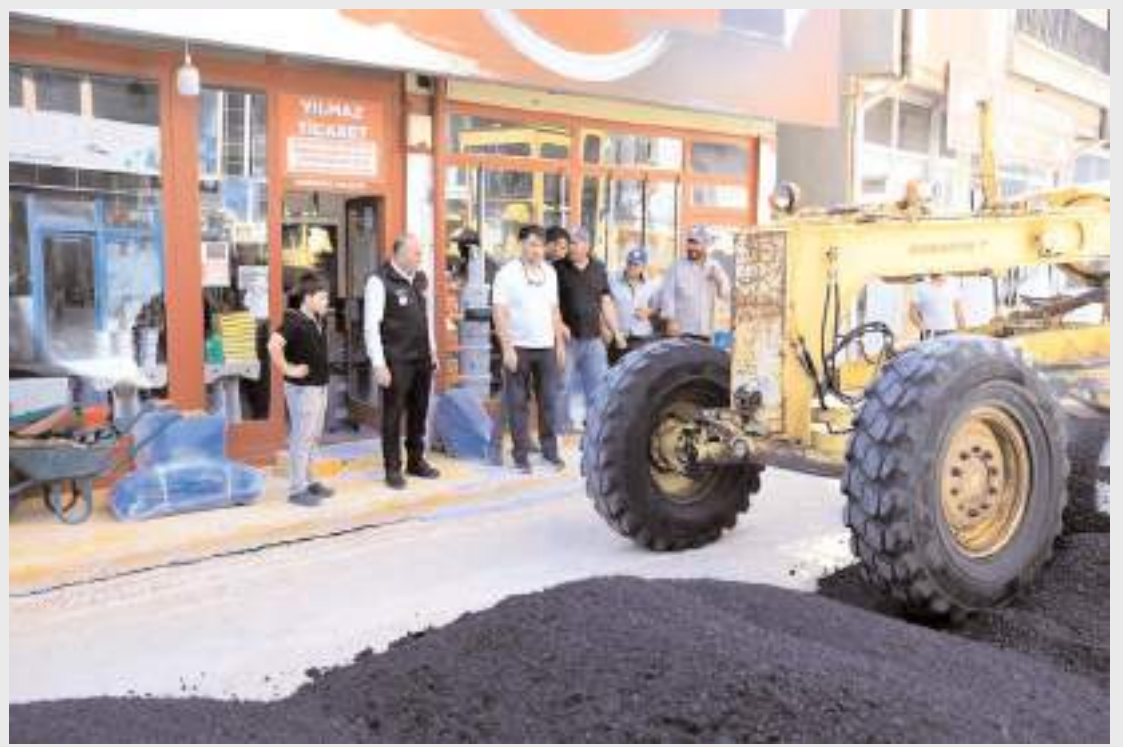
Alaca Belediyesi tarafından ilçe genelinde sürdürülen sıcak asfalt çalışmaları devam ediyor.
