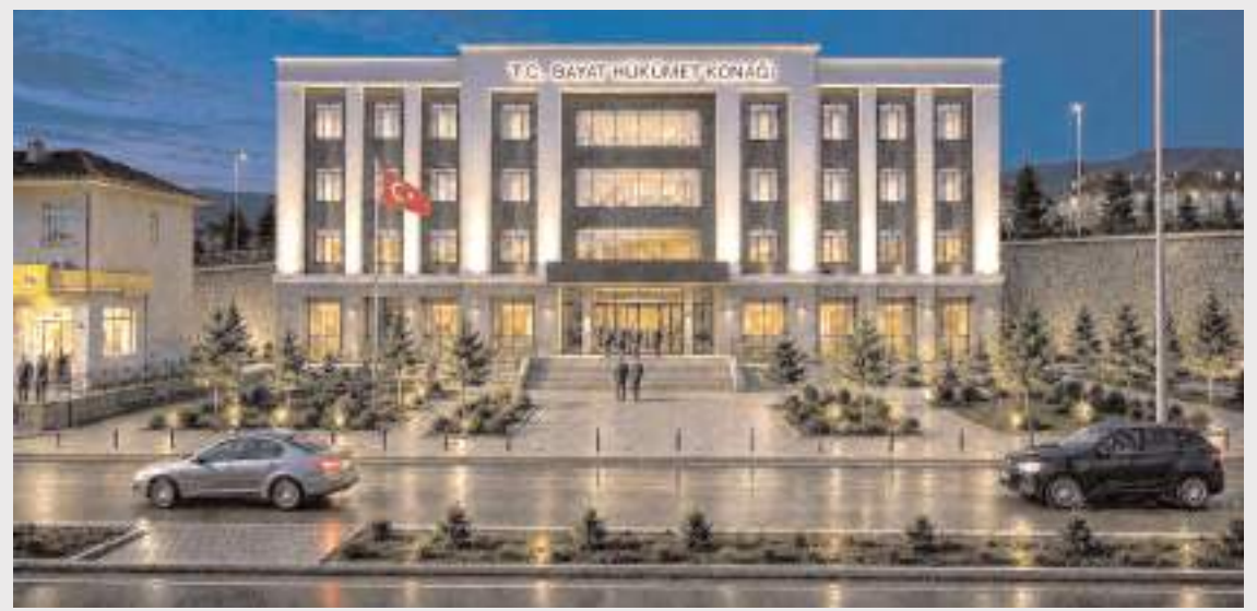
Kentsel dönüşüm Hükümet Binası'nın bulunduğu alanda yapılacak.
