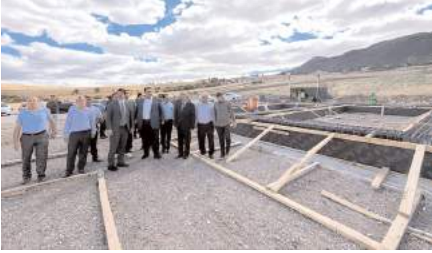
Milletvekili Kaya, inşaat alanında incelemede bulundu.
