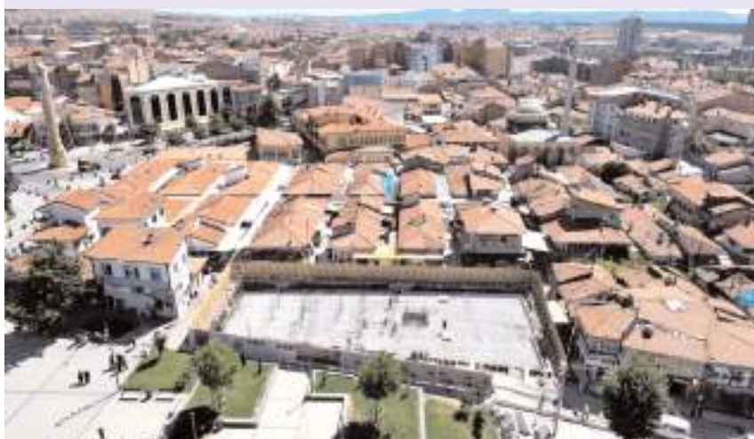
Çöplü Arastası 3. etap cephe sağlıklılaştırması yine belediye tarafından yapılacak.
