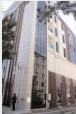
Çorum Barosu yeni hizmet binası
