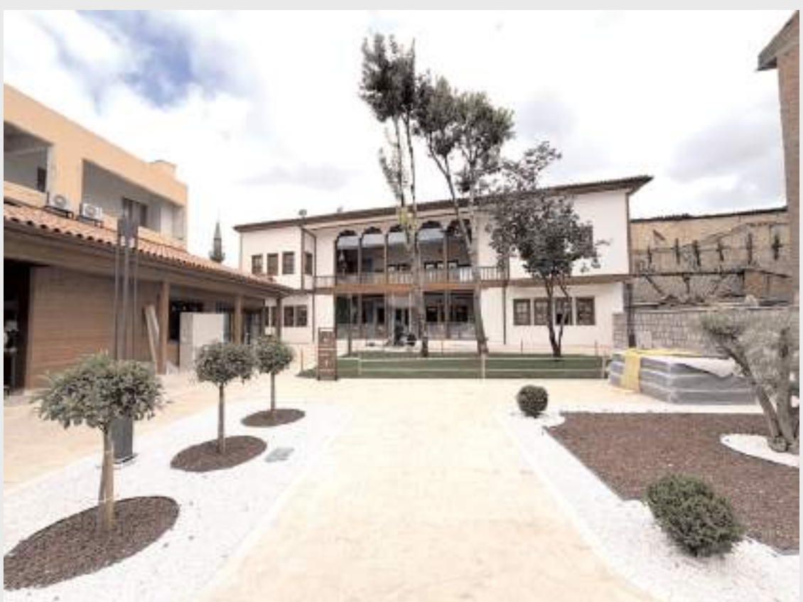
İkiz Konağın restorasyonu tamamlandı.
