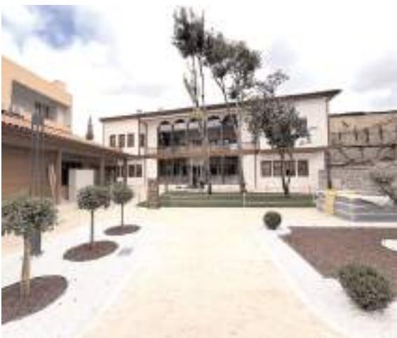
İkiz Konağın restorasyonu tamamlandı.
