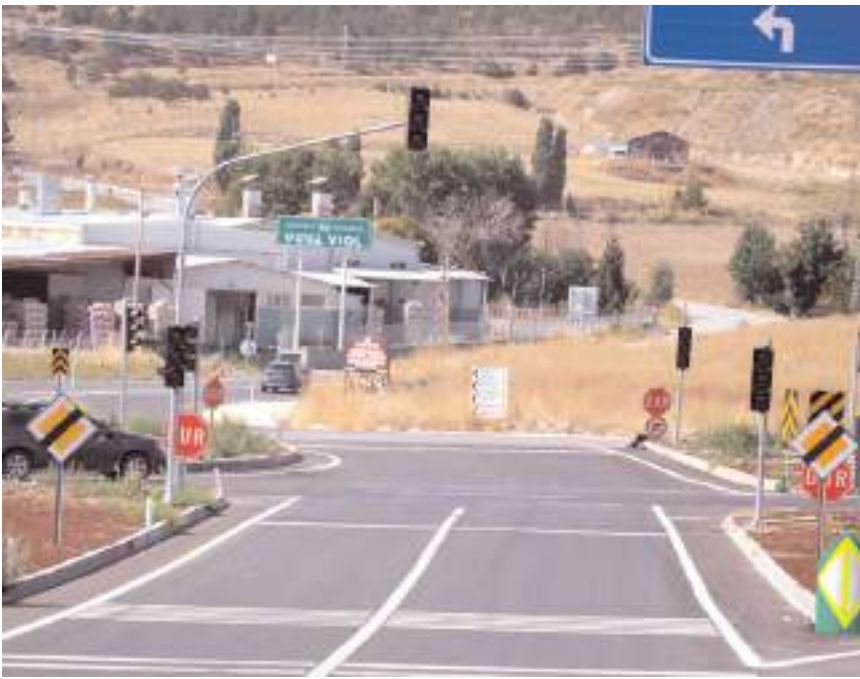
Kavpak yapıldýktan sonra kazaların artması üzerine sinyalizasyon sistemi kuruldu.
