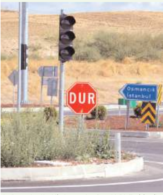
Sinyalizasyon sistemi kurulalı aylar geçmesine rağmen elektrik bağlantısı yapılmadı.
