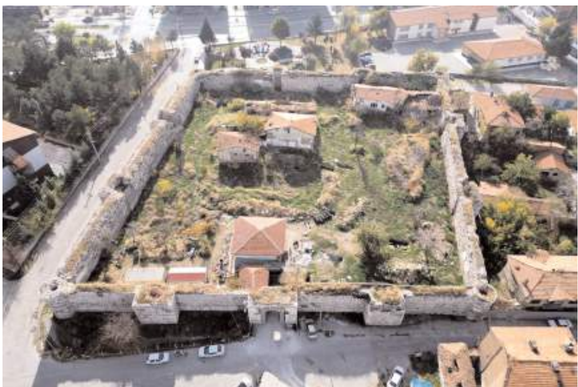
Projenin ilk etabında Kale içinde yer alan yapılar kamulaştırılarak yıkıldı.
