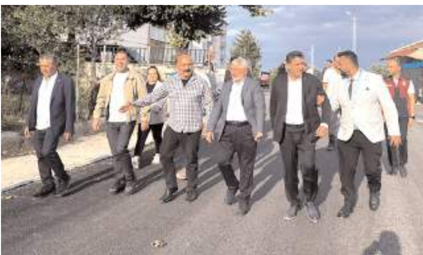
Başkan Aşgın, asfalt çalışmalarının yapıldığı yolda incelemede bulundu.
