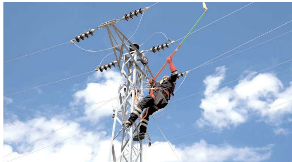
Ekipler, direk tipi dağıtım trafosunun yüksek gerilim tarafındaki arızalı sigortayı değiştirme görevini yerine getirdi.
