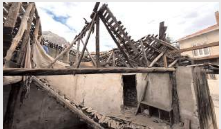
Fazlalar Konağı'nda restorasyon çalışmaları başladı.
