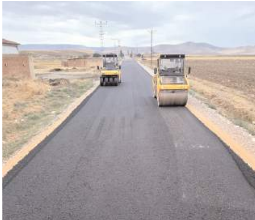
Mahmatlı köyü grup yolunda sıcak asfalt serimi tamamlandı.
