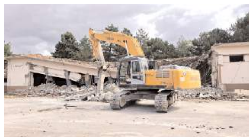
Proje kapsamında mevcut okul binası yıkılarak yerine 24 derslikli yeni bir eğitim binası inşa edilecek.
