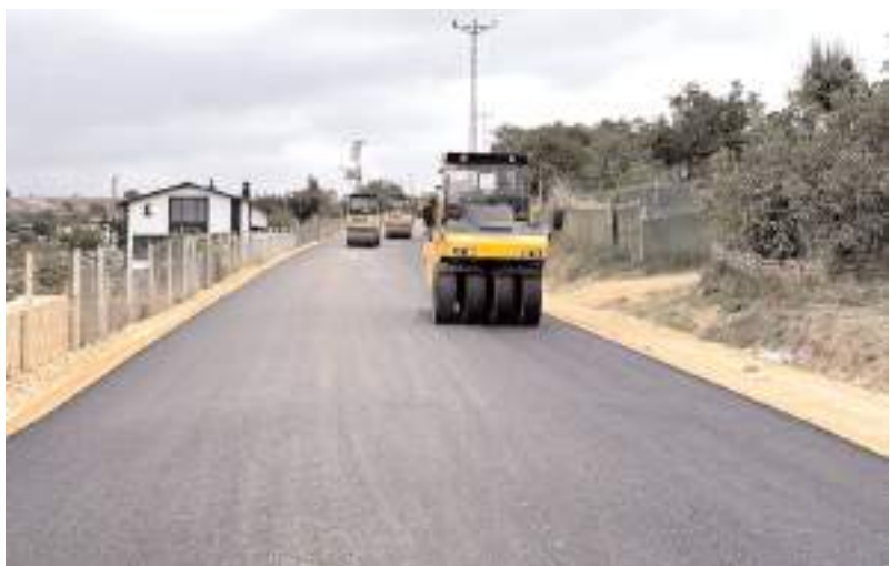
Eskiekin-Elmalı Grup Yolu'nda asfalt çalışmaları sürüyor.
