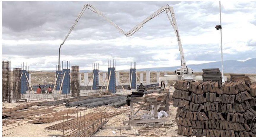
Zanaatkarlar'da demirci esnafı için yapımına başlanan 18 işyerinde inşaat çalışmaları sürüyor.
