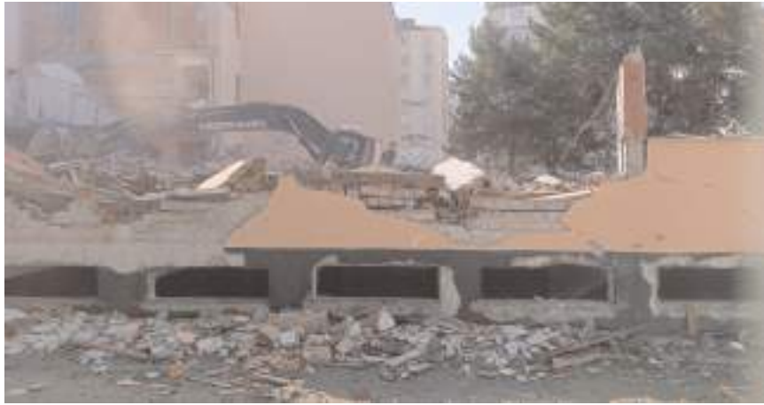
1950'li yıllarda inşa edilen Albayrak İlkokulu'nun yenilenmesi için yıkım çalışmaları başladı.
