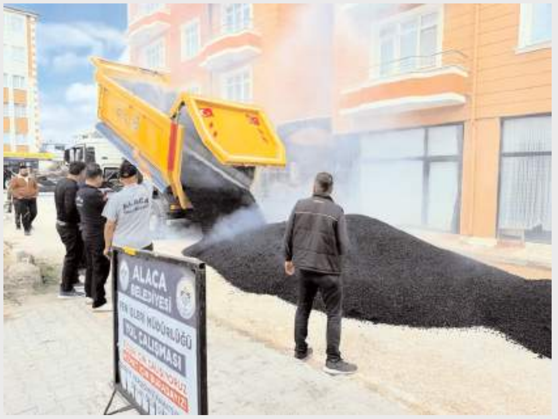
Alaca Belediyesi tarafından sıcak asfalt çalışmaları devam ediyor.
