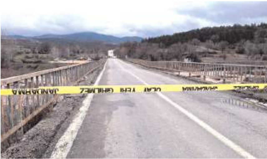
Çomu Çayı Köprüsü yeniden inşa edilecek, bağlantı yolları yenilenecek.
