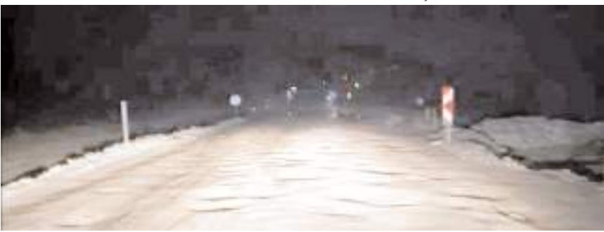
Çorum-İskilip yolunda yapım çalışmaları devam ediyor.
