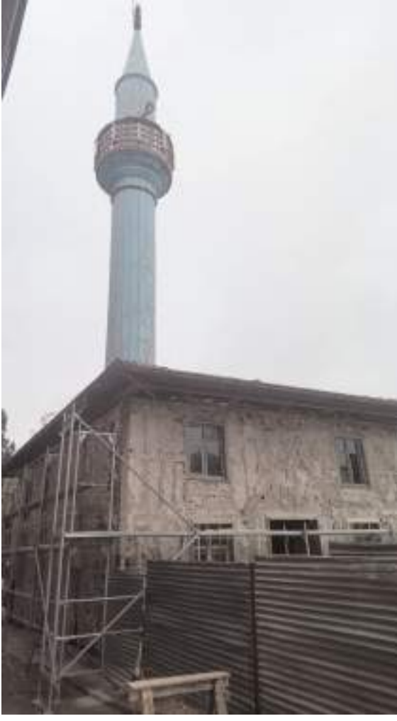
Çalışmalar kapsamında camiye sonradan eklenen yerler temizlenecek.
