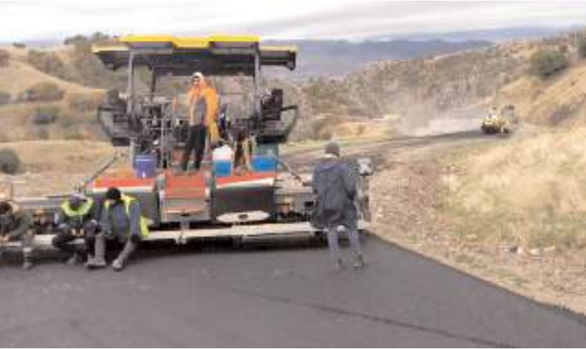
Yaklaşık 400 hane ve 1125 kişinin yaşadığı köyde, bozuk yollar yeniden asfaltlanıyor.
