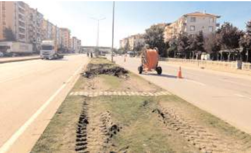
Hızlı tren hattının iletişim altyapısını oluşturmak amacıyla fiber optik kablo döşeniyor.
